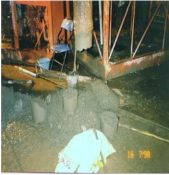
รูปที่ 4 คอนกรีตอัดแน่นในท่อ เทเนื่องจากคอนกรีตเกิดการผันแปรจากการเข้มน้ำ
